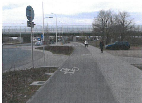
ZDJĘCIE 19 Polska, Wrocław. Ciągłość nawierzchni drogi rowerowej na przecięciu z jezdnią/zjazdem.
